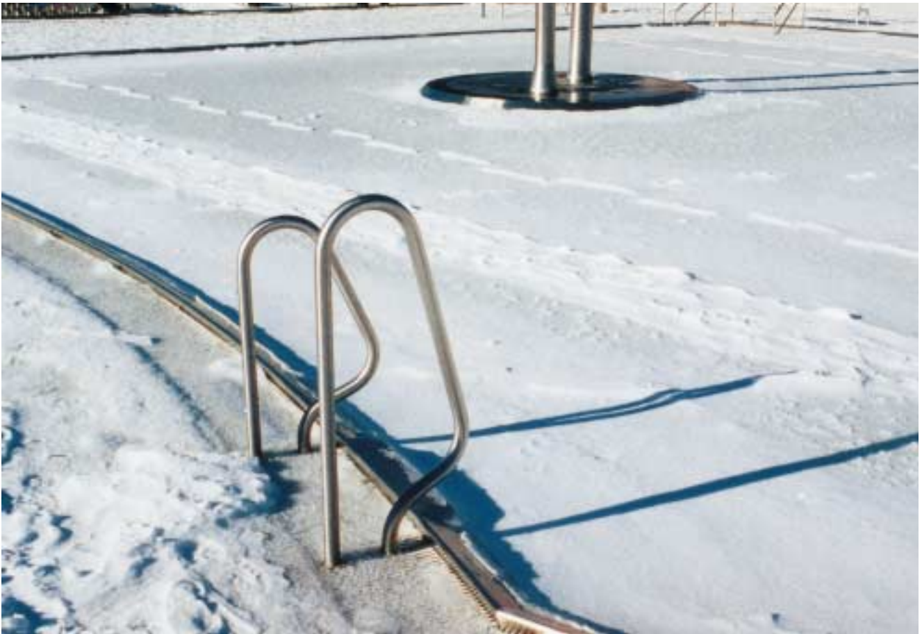
Seine Frostsicherheit macht Edelstahl Rostfrei zum bevorzugten Werkstoff gerade bei Freibädern.
