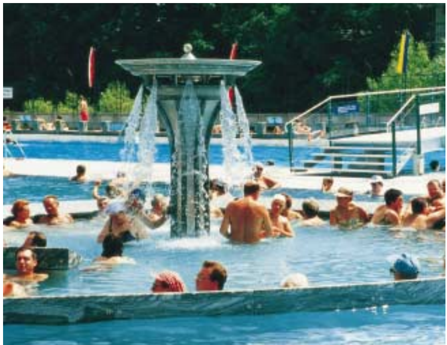
Angenehme Atmosphäre nach der Flutung: Edelstahl Rostfrei ist optisch ansprechend, hier in Kombination mit Granit, und korrosionsbeständig, besonders in stark erwärmtem Wasser und in der dadurch hochchloridhaltigen Luft.
